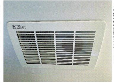
浴槽の上に設置した浴室暖房器。ヒートショックを防ぐため、居室と浴室の温度差をなくそう
